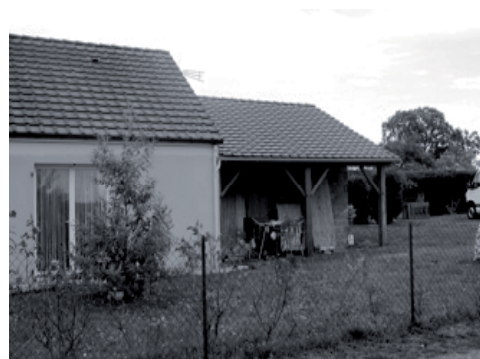
Extension auto construite - Thenay
