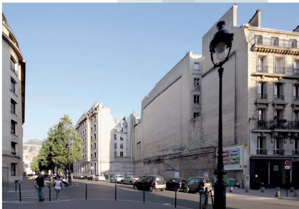
Vue de la parcelle après démolition de la station-service
